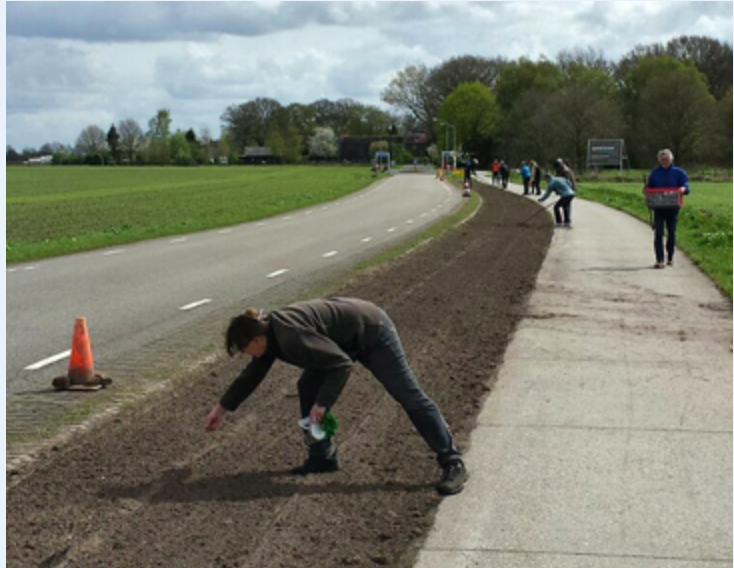
Inzaaien van een berm in Benneveld
